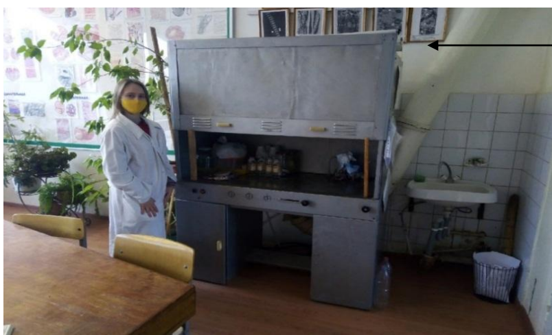
Рисунок 1 – Учебная аудитория 221 с вытяжным шкафом, где изготавливаются анатомические препараты. А-воздуховод вытяжного шкафа
